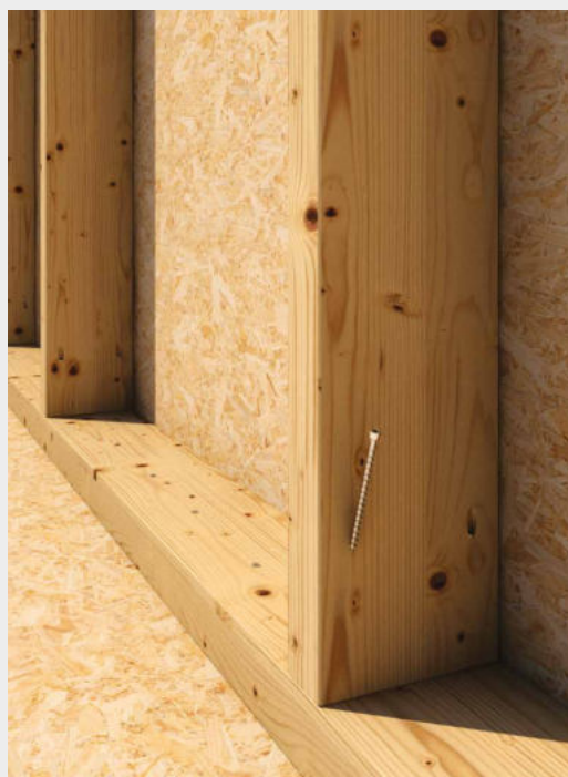
Vieglā karkasa konstrukciju statņu stiprināšana.
