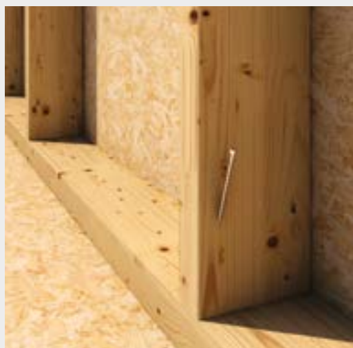
^ Pričvršćivanje stupova u konstrukcijama s laganim okvirom uz VGZ EVO Ø5 mm.
