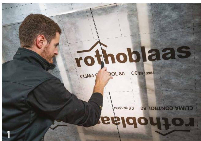
1 CORTAR EL CENTRO DE LA LÁMINA EN EL HUECO DE LA VENTANA Para cortar la lámina por el centro del hueco de la ventana, utilizar el cúter MARLIN.
