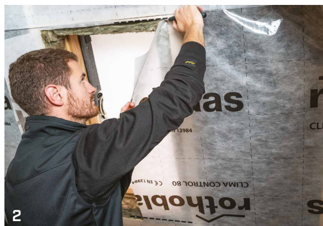
2 CORTAR LA LÁMINA EN EL BORDE DE LA VENTANA DE TECHO Con el cúter, cortar la lámina siguiendo el borde superior y el inferior de la ventana.
