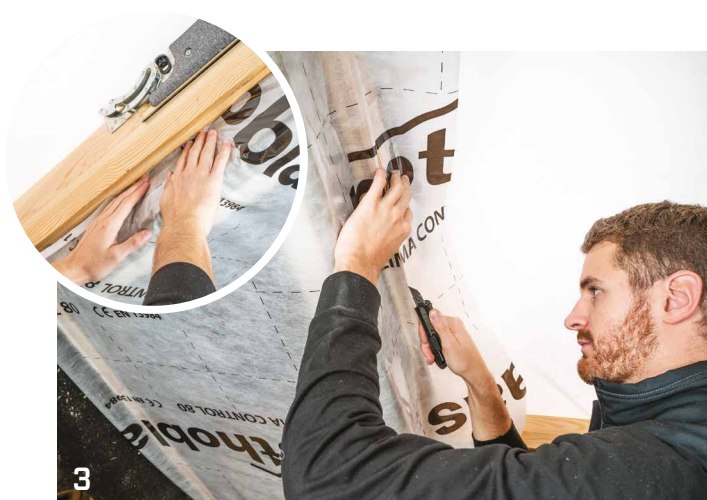
3 DOBLAR Y ENCINTAR LOS LADOS DE LA LÁMINA Cortar el exceso de lámina, doblar con esmero los bordes y fijarlos con cinta Rothoblaas.
