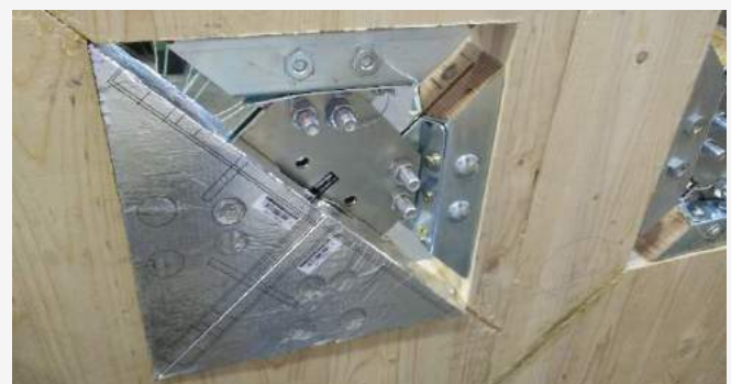
Montage der X-SEAL-Komponenten
